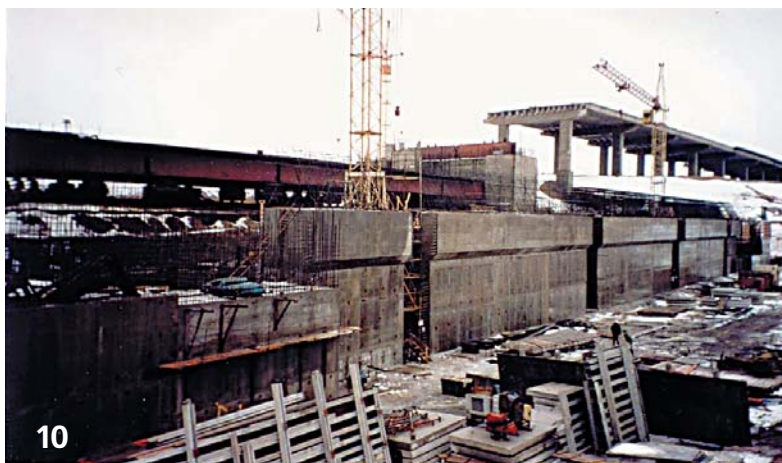
10. Современная ситуация на строительстве судопропускного сооружения С-2
